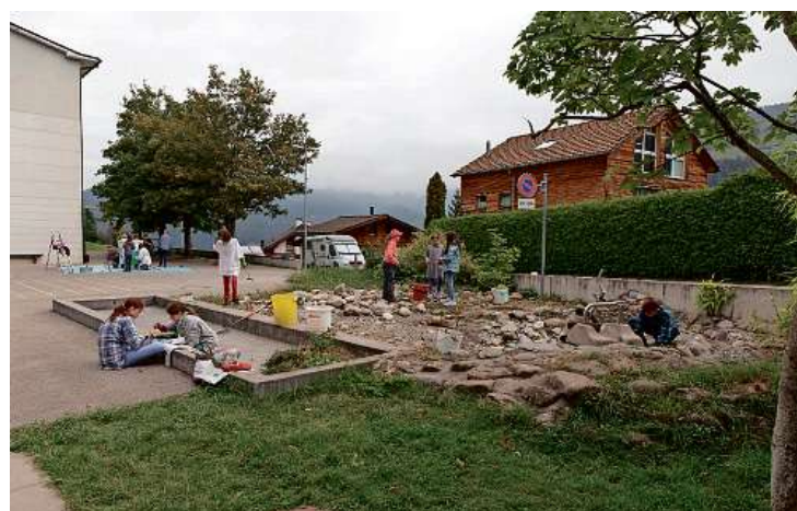
Bei den Umgebungsarbeiten wird gemeinsam Hand angelegt.
