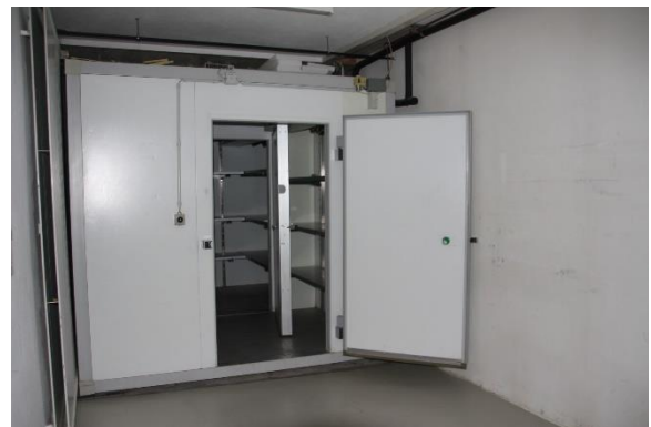
Kühl- und Gefrierraum wird ausgebaut
